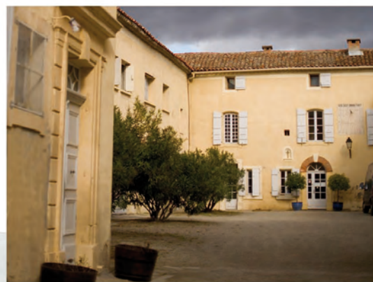
Puech Cocut : Cave du Château de Raissac
